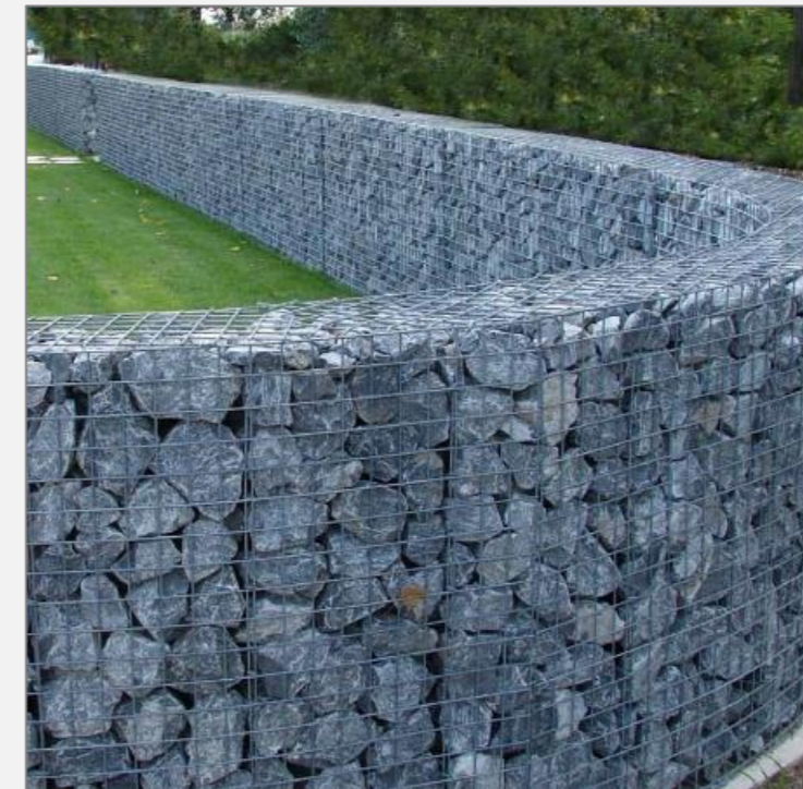
Figure 31 : Exemple d'un aménagement de gabion
